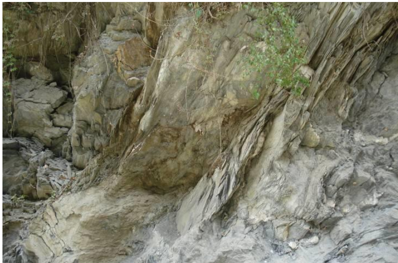
照片 2.4-7 断裂破碎带局部照片（镜向 SE）
