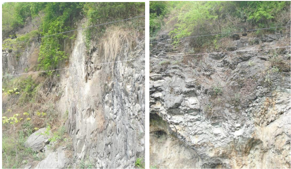
图 2.4-10 乾佑河附近 F 7 断层面及破碎带局部照片（镜向 NWW）
